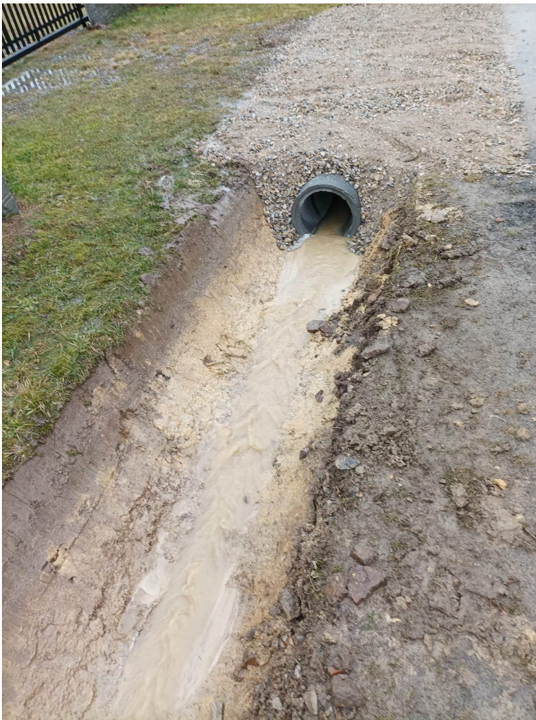
- montaż przepustów, wykonanie odwodnienia przy drogach
