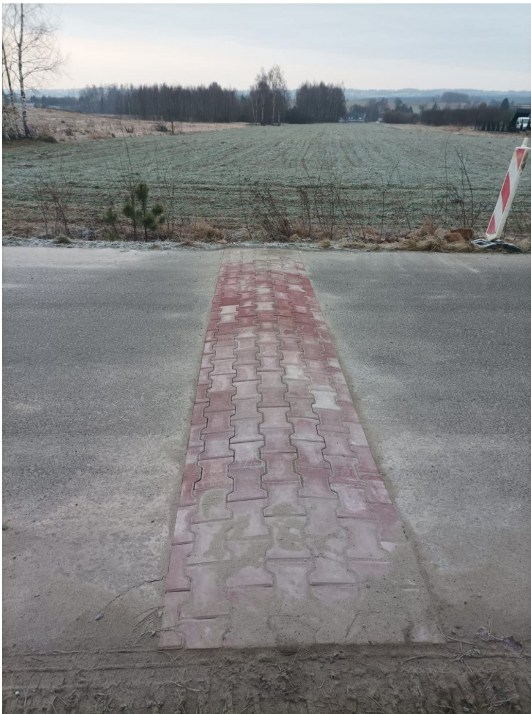
- budowa progów zwalniających
