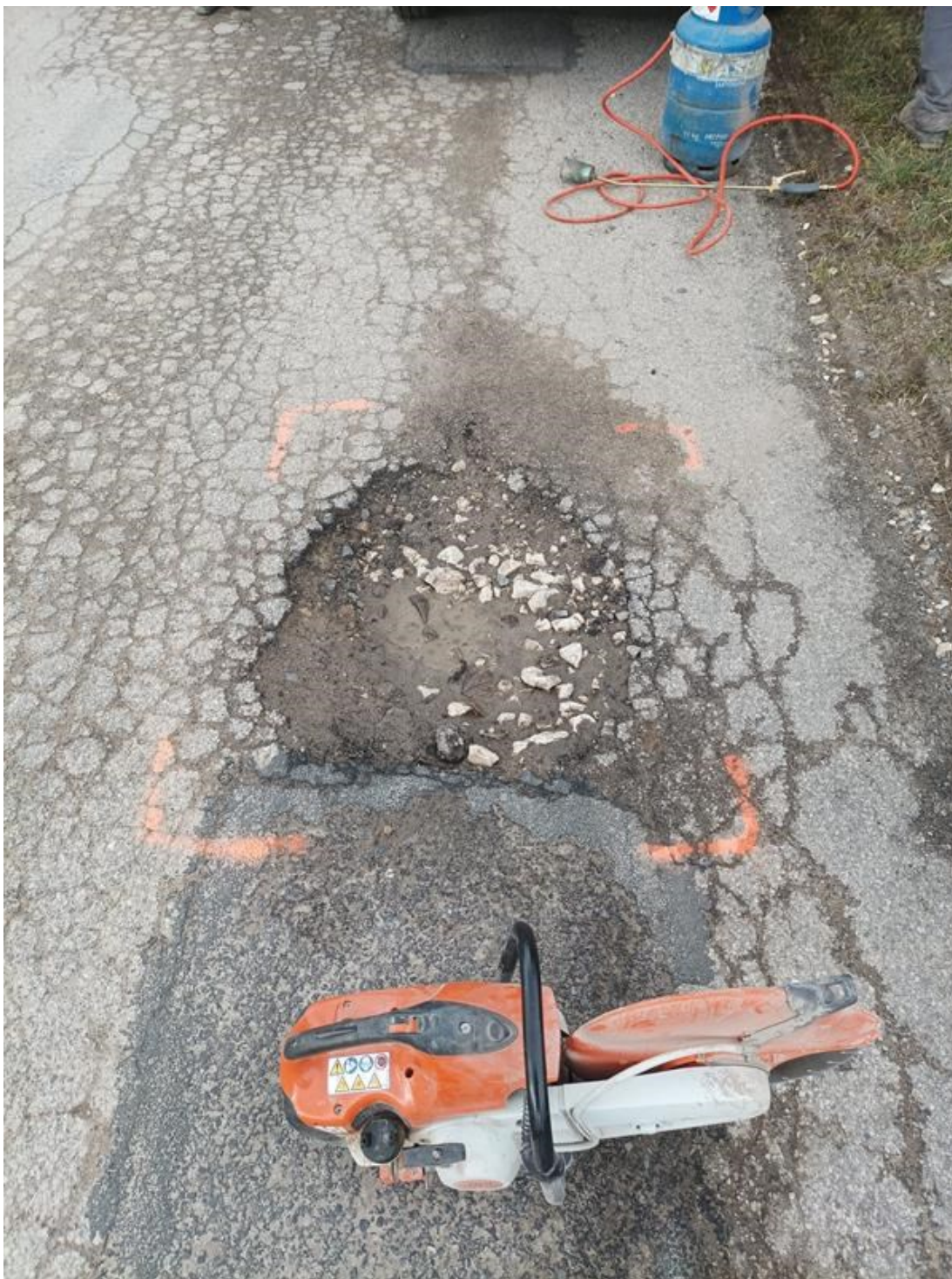
- bieżąca naprawa ubytków w drogach gminnych masą asfaltową
