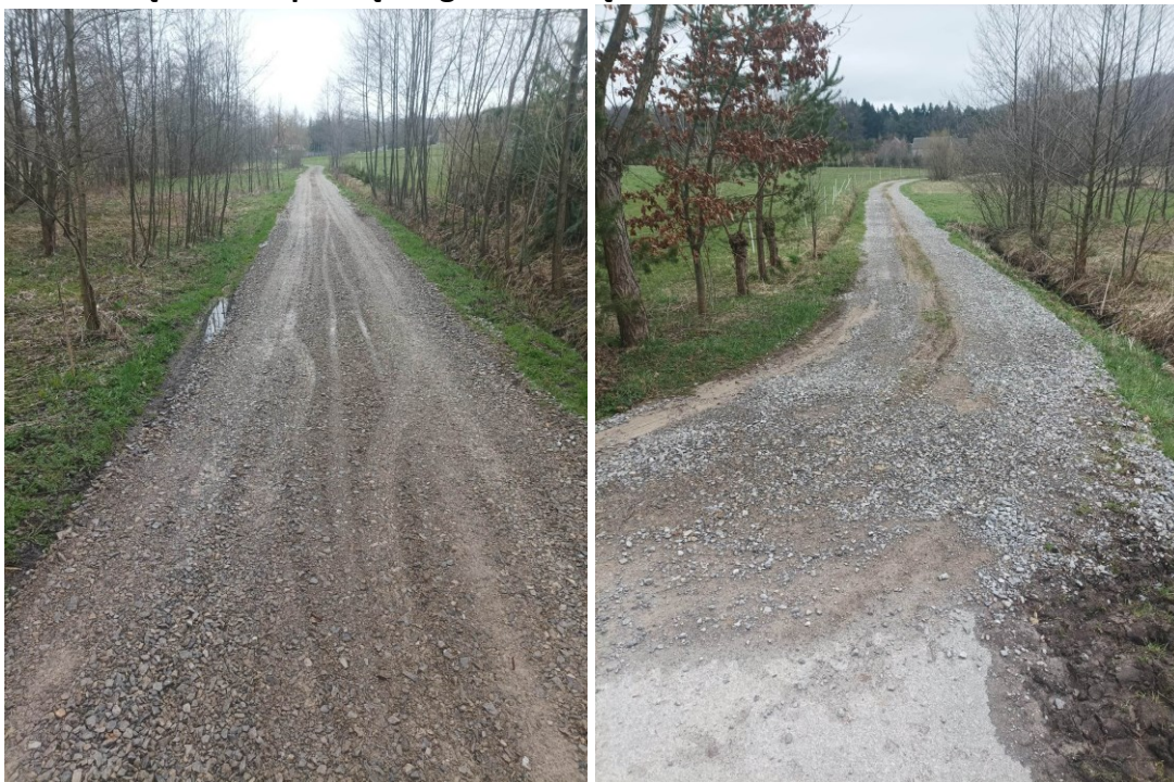
Prace związane z naprawą drogi w msc. Sėdek- Gwiździowa
