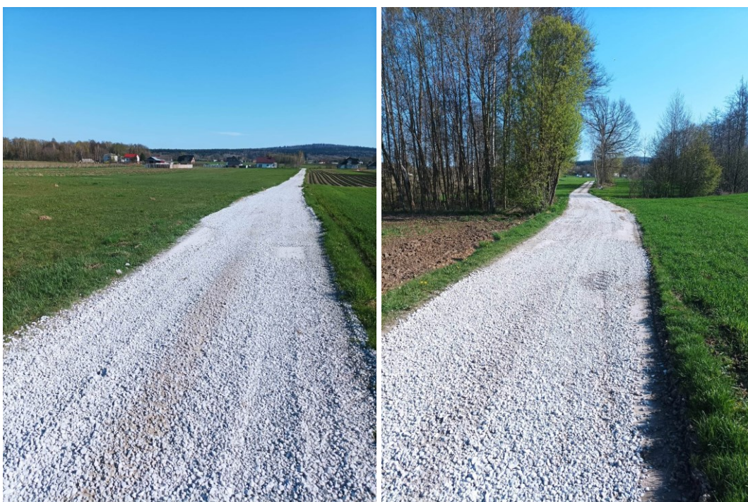
Prace związane z naprawą dróg nr 22, 82, 35 w miejscowości Wiśniowa.
