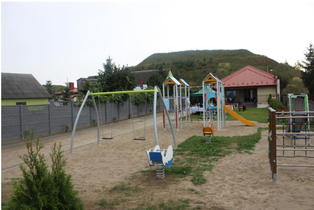
Budowa placu zabaw wraz z zagospodarowaniem terenu przy świetlicy w Nowym Stawie
